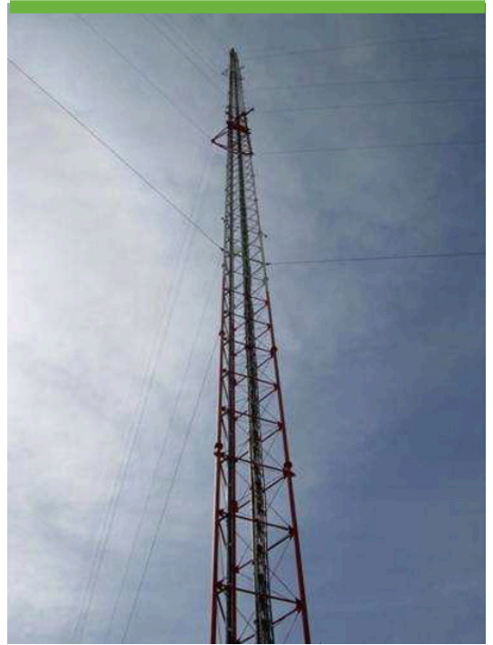
图为爱荷华州森特维尔市 Penn State 塔，采样高度为地面以上 30 米（100 英尺）和 110 米（360 英尺）
